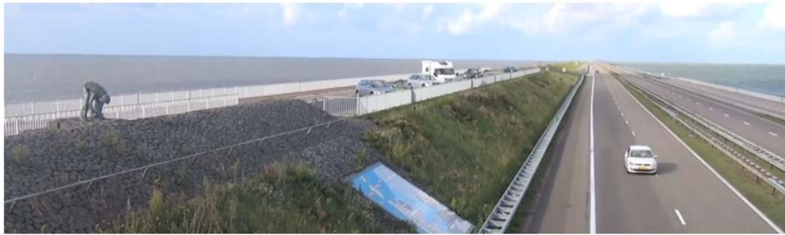
Photo 1. Digue de fermeture du golfe Zuiderzee, (cliché ©Beynet, 2014).
