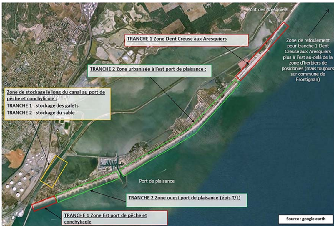
Figure 3. Travaux effectués sur lido de Frontignan (SMBT).
