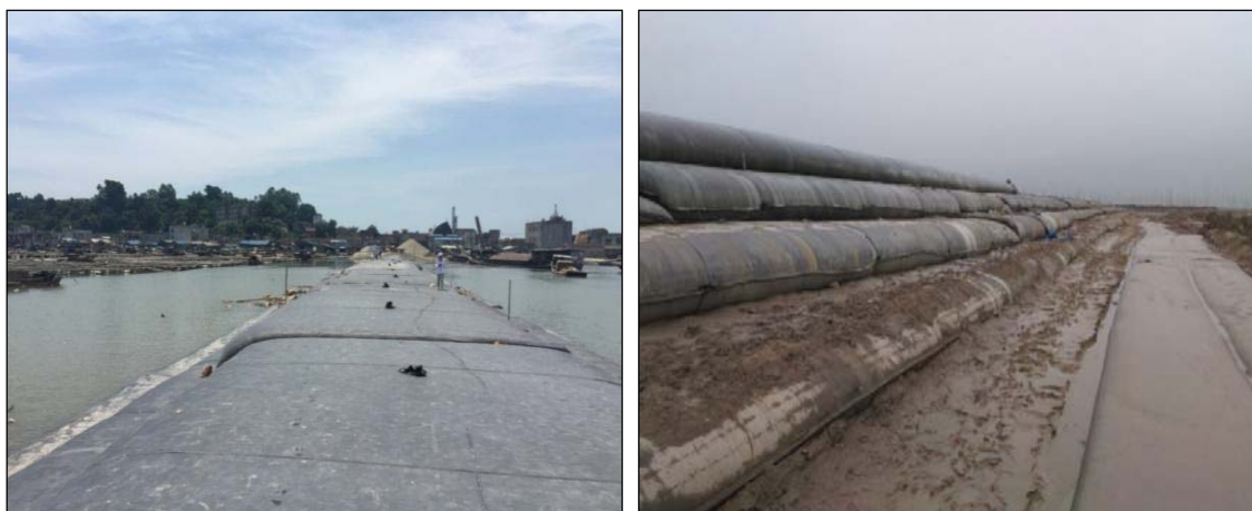
Figure 4. Corps de la digue en cours de réalisation.
