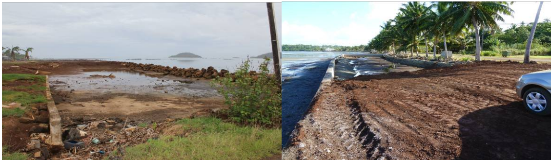
Figure 3. Exemples de remblais édifiés sur le platier frangeant.
