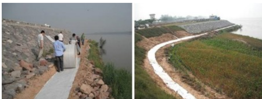
Figure 7. Pose de la bande capteur composite sur la berge intermédiaire.
