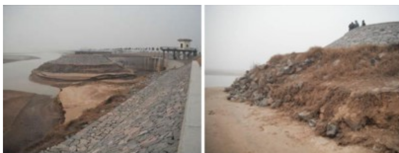
Figure 6. Éperon de la digue de protection montrant une forte érosion externe en pied.
