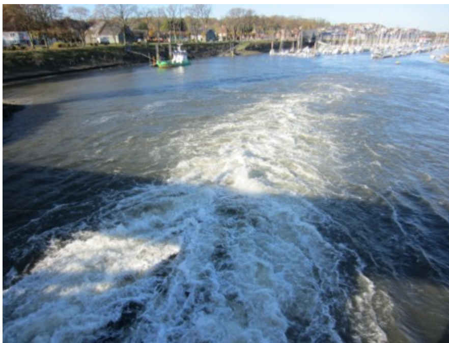
Figure 5. Zone de turbulence à l'aval du barrage inférieur.
