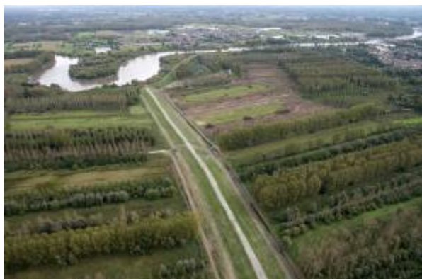
Figure 5. Digue de compartimentation achevée – automne 2013.
