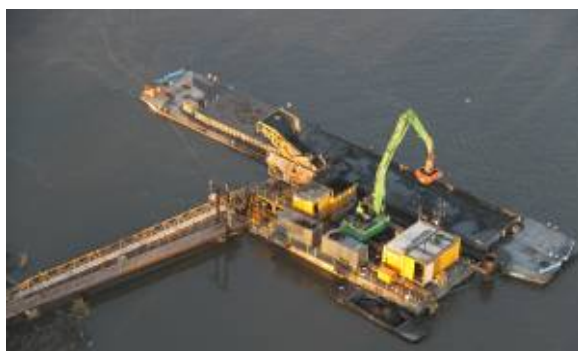
Figure 3. Plateforme de déchargement avec installation de pompe.
