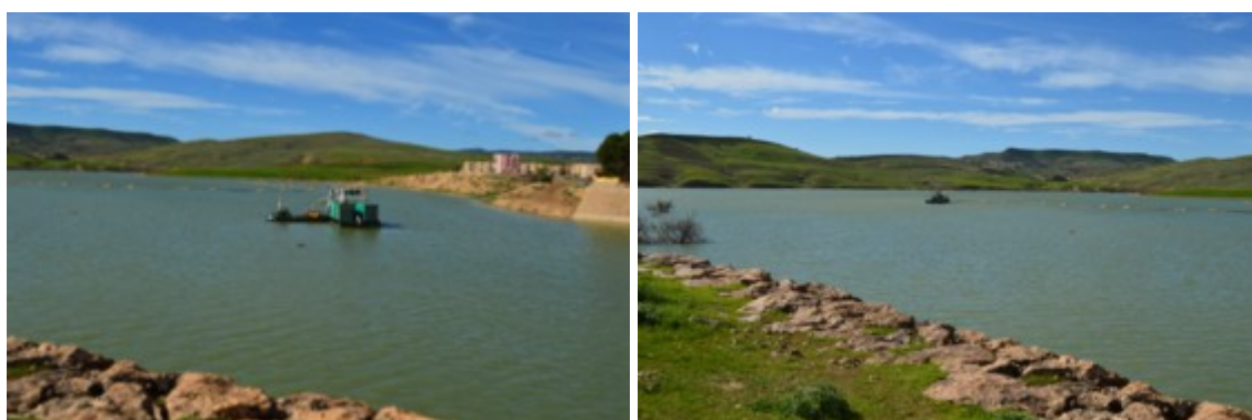
Figure 4. Photos du matériel de dragage dans la retenue du Barrage de Bouhanifia (Photos Equipe Mekerta).
