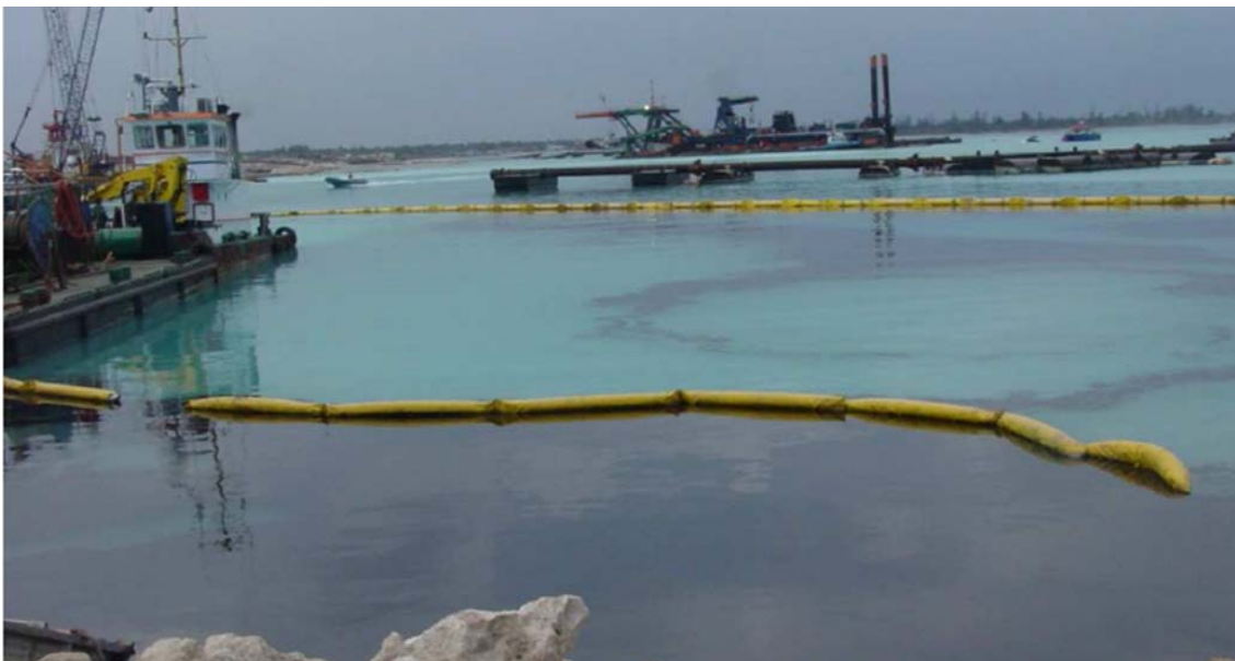
Figure 1. Barrages flottants canalisant les matières polluantes vers des poches amovibles jetables.
