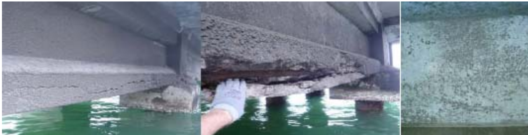
Figure 7. Fracture, aciers corrodés et fissure oblique sur poutres du quai n°9 de Jarry.
