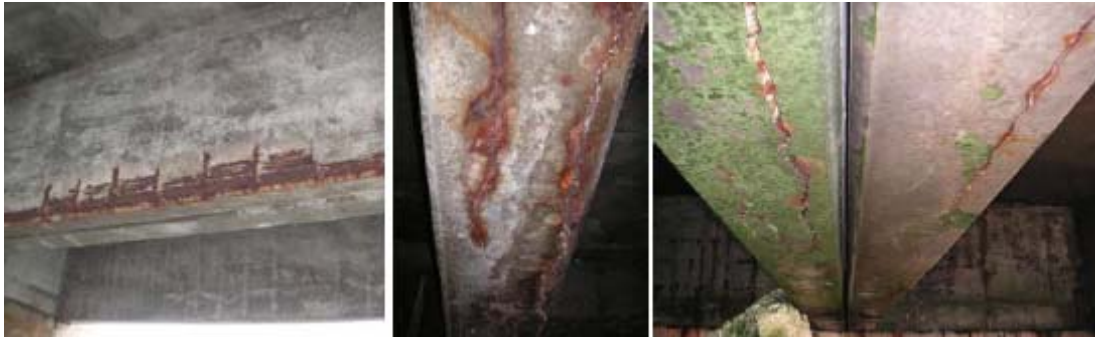
Figure 6. Dégradations du béton armé des caissons du quai Modéré Lombard.
