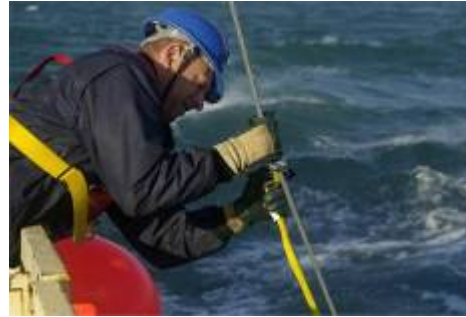
Figure 2. Fixation des tuyaux sur le câble porteur
