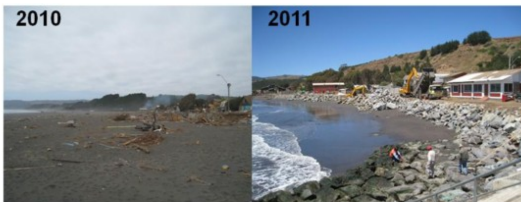
Figure 3. Baie de Duao, à 8 km au nord de Mataquito immédiatement après le tsunami en mars 2010 et un an plus tard en janvier 2011. La plage s'est érodée d'environ 200 m, des enrochements sont mis en place.
