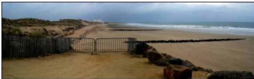
Figure 3. Batterie d'épis prise du haut du perré des Becs vers le sud.
