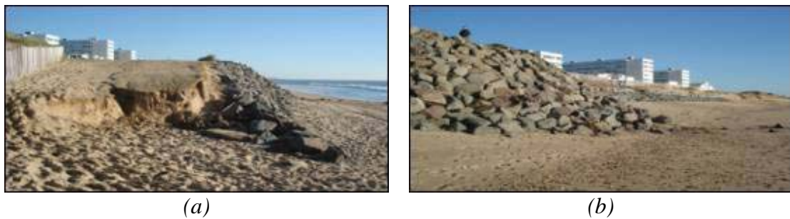
Figure 2. Site des Mouettes Nord du perré : (a) Érosion à l'extrémité; (b) Pied de talus.
