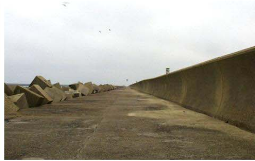
Mur de couronnement / chasse mer (CETMEF)
