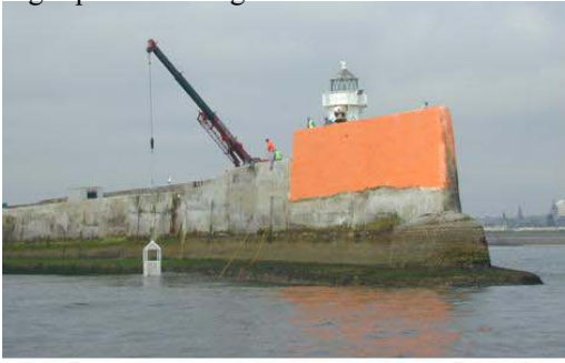
Mur de digue (Port d'Aberdeen)
