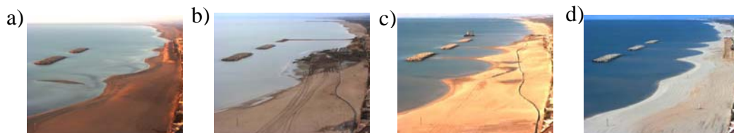
Figure 4 : Suivi des travaux de protection réalisés sur le littoral de Valras-Plage
