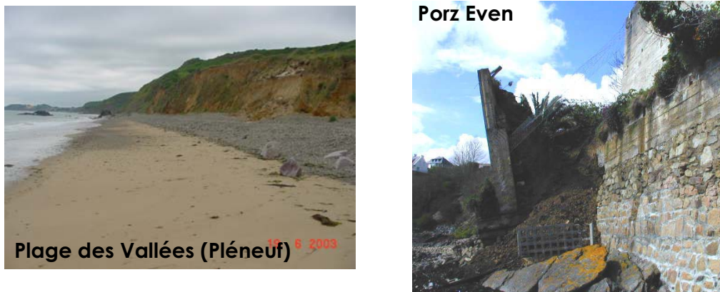
Fig. 4 : Exemples d'instabilité des falaises meubles quaternaires.
