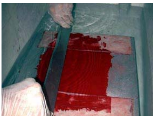
Figure 1 : L'application du revêtement n° 5 est délicate mais excellente adhérence
