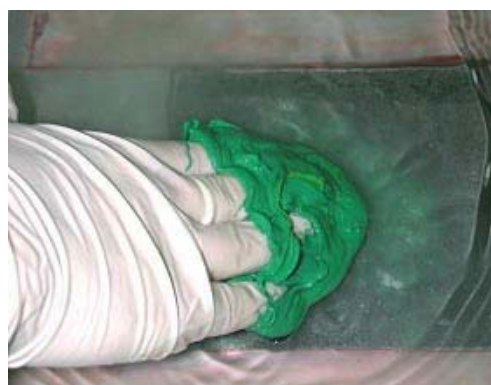
Figure 2 : L'application du revêtement n°7 est impossible
