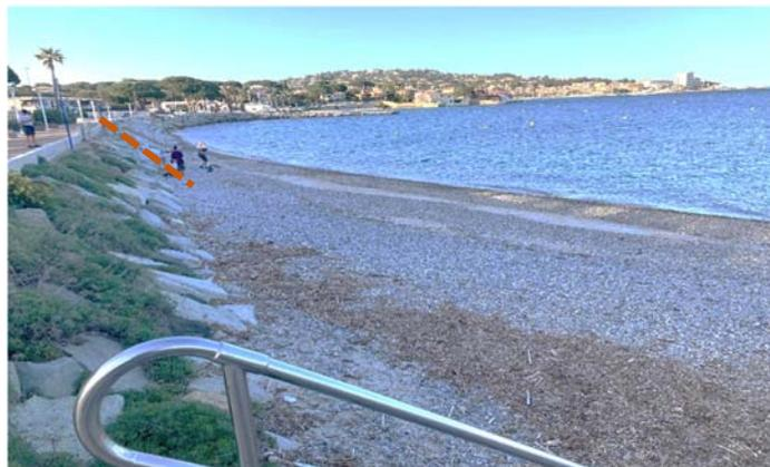
Figure 6. L'érosion de cette baie ouverte sur le SW, à l'«abri» d'un épi, signale un défaut d'accrétion structurel. Un PLT-Littoral peut corriger la zone concernée en rétablissant la plage et en évitant la submersion de la digue.
