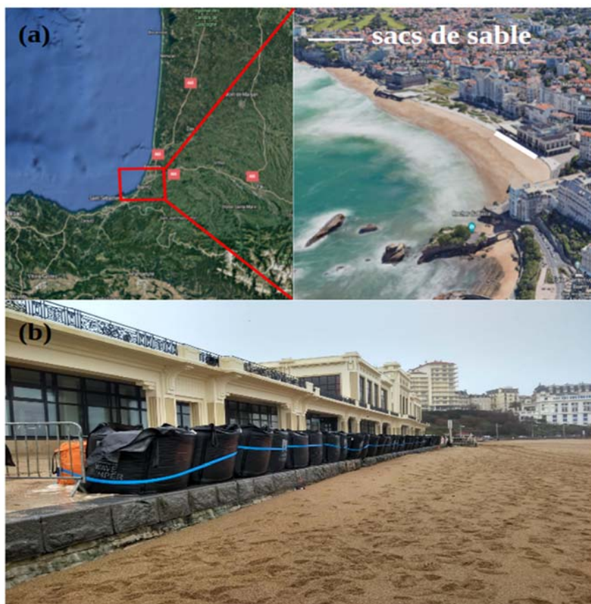
Figure 1. Site de La Grande plage de Biarritz : (a) Volet gauche : localisation de la côte basque française à l'échelle du sud-ouest de la France, volet droit : position de la barrière de protection temporaire. (b) Photo des unités de sacs de sable d'un m^3 de volume.
