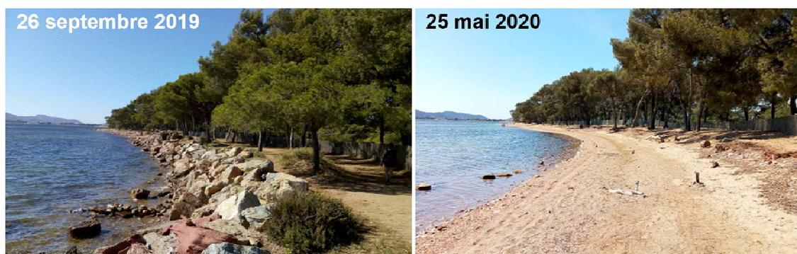
Figure 3. Zone enrochée en 2019 et désenrochée en 2020 (MTPM).
