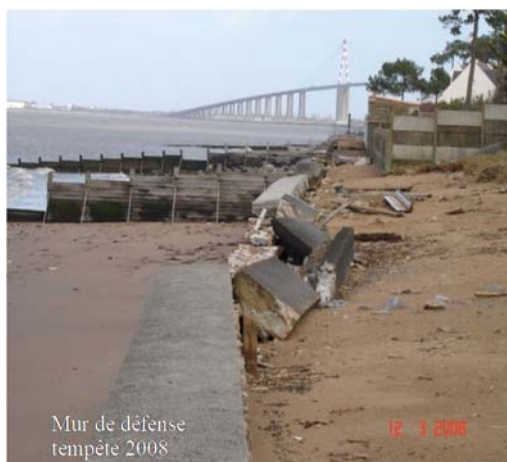
Figure 8. Mur de défense après la tempête de 2008.
