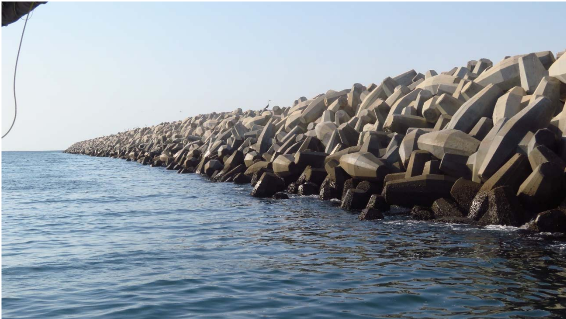
Figure 3. Face extérieure protégée par des blocs CORE-LOC™ des digues du port de pêche, (@CLI).
