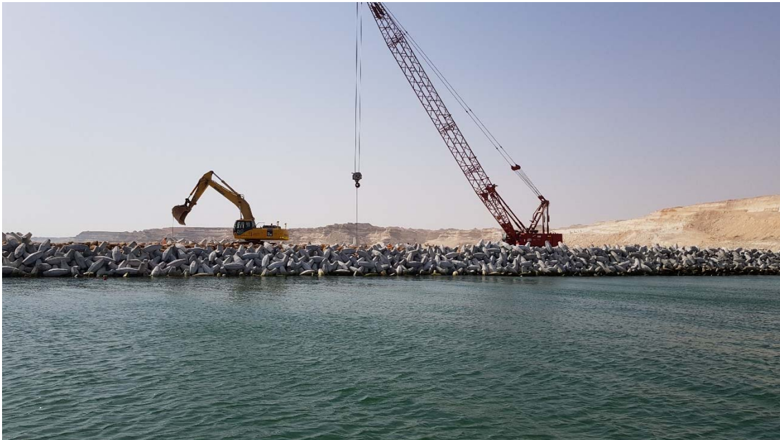
Figure 2. Construction de la carapace CORE-LOC™ sur le musoir de la digue secondaire du port de pêche au Sultanat d'Oman, @CLI.
