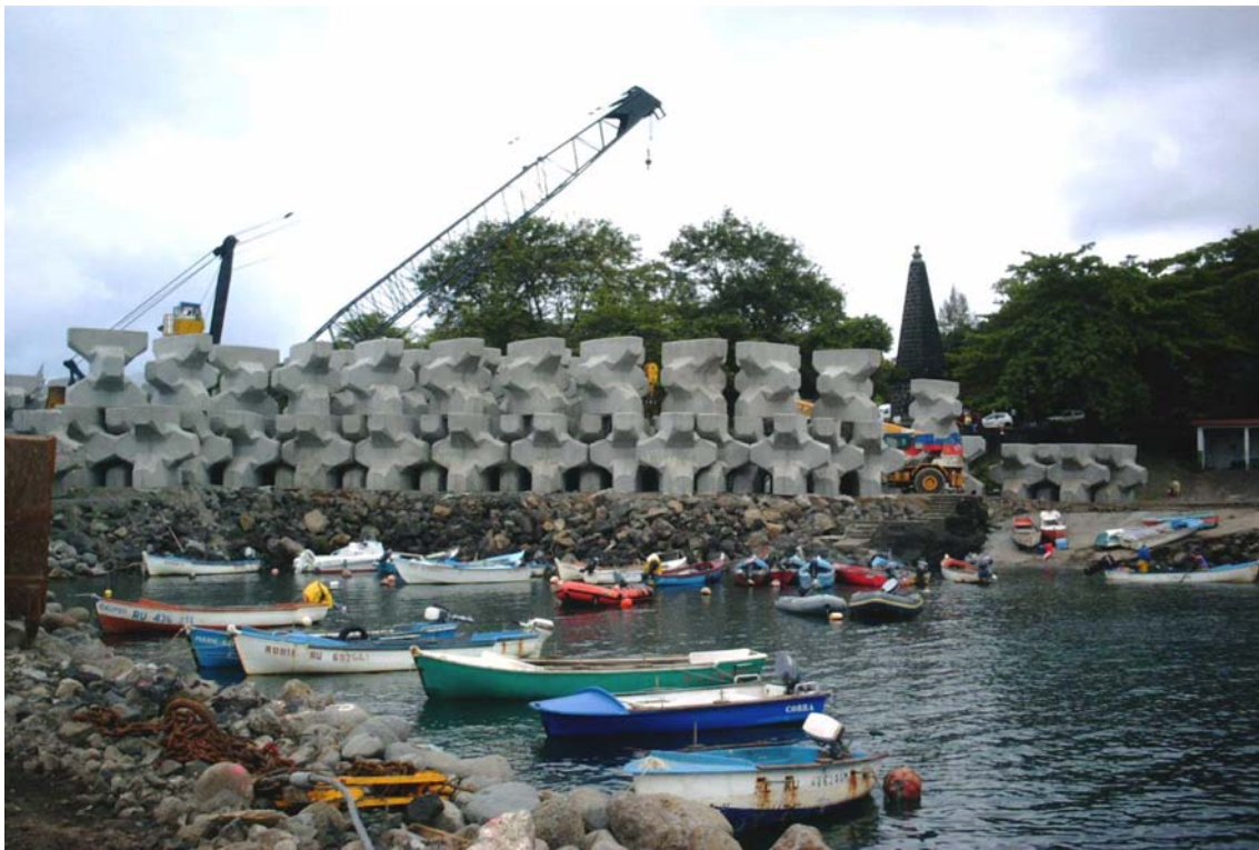
Figure 1. Préfabrication des blocs ACCROPODE™ 12 et 16m 3 sur le site de la marine de Sainte-Rose en 2000, (@ ARTELIA).
