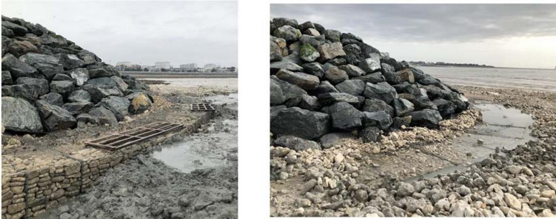
*Figure 4. Photographie de l'installation de la butée de pied et du remplissage des gabions.*
