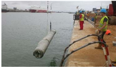
Figure 12. Descente d'un matelas à dérouler par des plongeurs.
