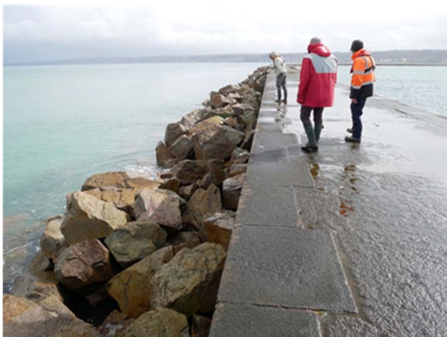
Photo 1. Vue des enrochements naturels existants de la digue de l'Est.
