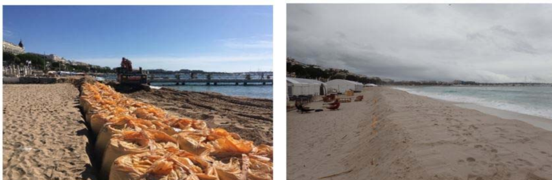
Figure 1. Plages de la Croisette pendant les travaux de ré ensablement et exemple de merlon en big bags mis en place sur le secteur Bâoli (Photographie : ICTP, 2017).
