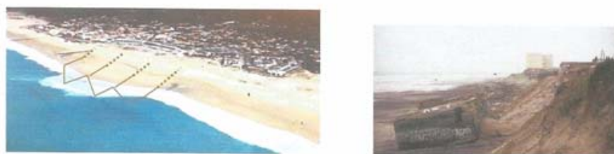
Figure 1. Ouvrage "PL-Littoral «de "bas estran" (à gauche) ; Localisation d'un ouvrage d'art "de trait de côte", à droite.
