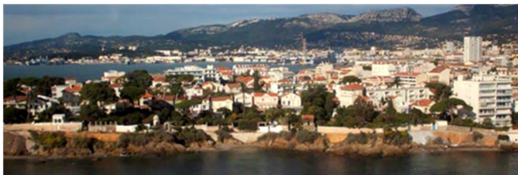
Figure 12. Vue d'hélicoptère du tronçon.
