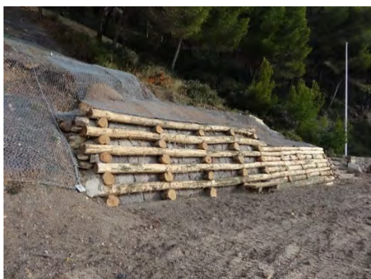
Figure 10. Vue du gabion bois après finition des travaux (2013).
