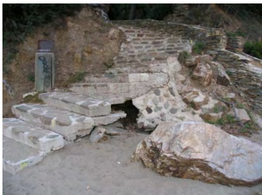
Figure 1. Base de l'escalier Ouest avant travaux.
