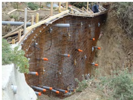
Figure 17. Paroi clouée en cours, drains et tuyau de collecte EP visible.
