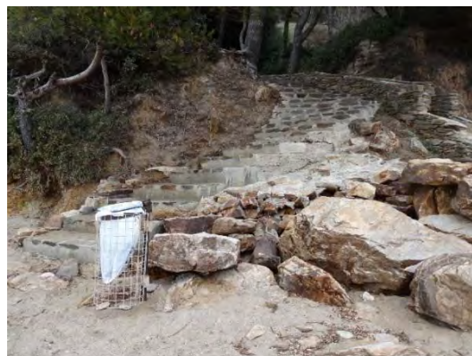
Figure 2. Base de l'escalier Ouest après travaux.
