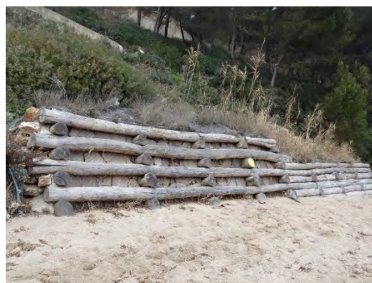
Figure 11. Vue du gabion bois en 2016.
