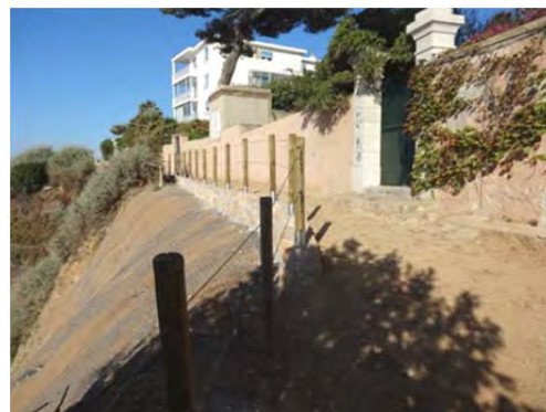
Figure 14. Longrine, garde-corps et pavage vus du sentier.
