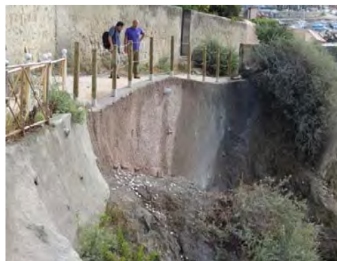
Figure 18. Paroi clouée terminée et test de coloration.
