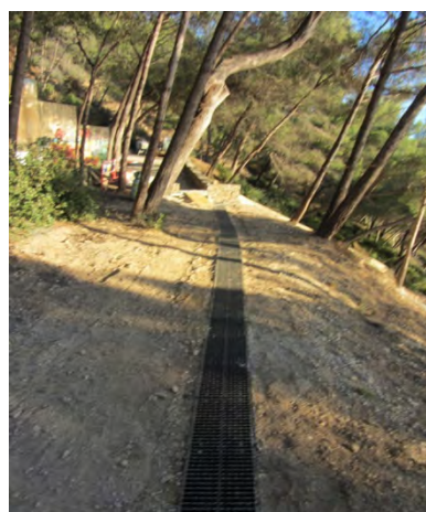
Figure 8. Caniveau sur plateforme amont bas de versant.
